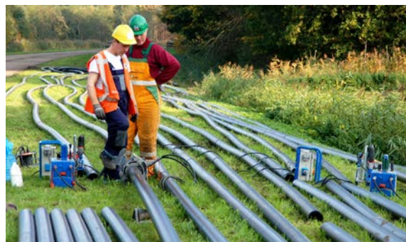
Kabels en leidingen worden uitgelegd
