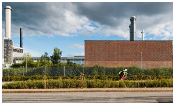
Pompgebouw voor restwarmte, Finland (door Virkkunen & Co)
