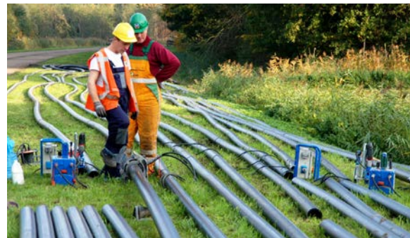
Kabels en leidingen worden uitgelegd
