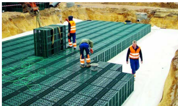
Kratten voor waterretentie neerleggen
