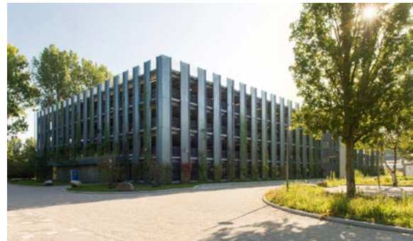
Tijdelijk modulair parkeergebouw, TU Delft
