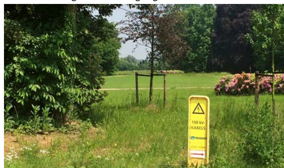
Waarschuwingsteken voor ondergrondse kabels
