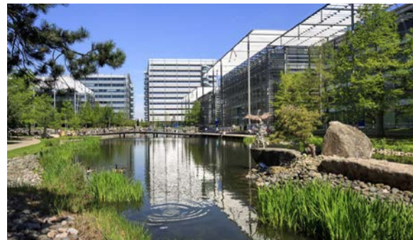
Retentievijver bij een bedrijfsgebouw
