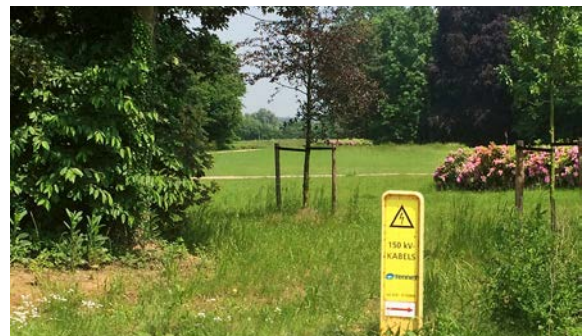
Waarschuwingsteken voor ondergrondse kabels
